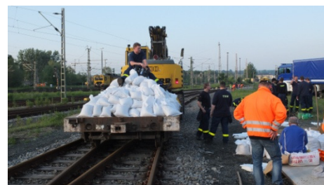
Oberes Elbtal (Sicherung ESTW Pirna)
