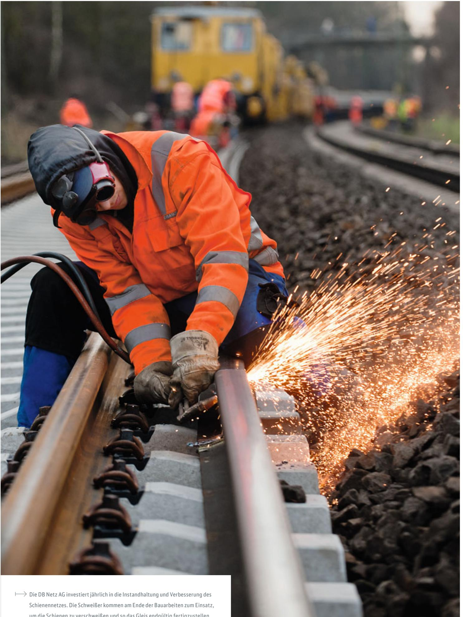
→ Die DB Netz AG investiert jährlich in die Instandhaltung und Verbesserung des Schienennetzes. Die Schweißer kommen am Ende der Bauarbeiten zum Einsatz, um die Schienen zu verschweißen und so das Gleis endgültig fertigzustellen.
