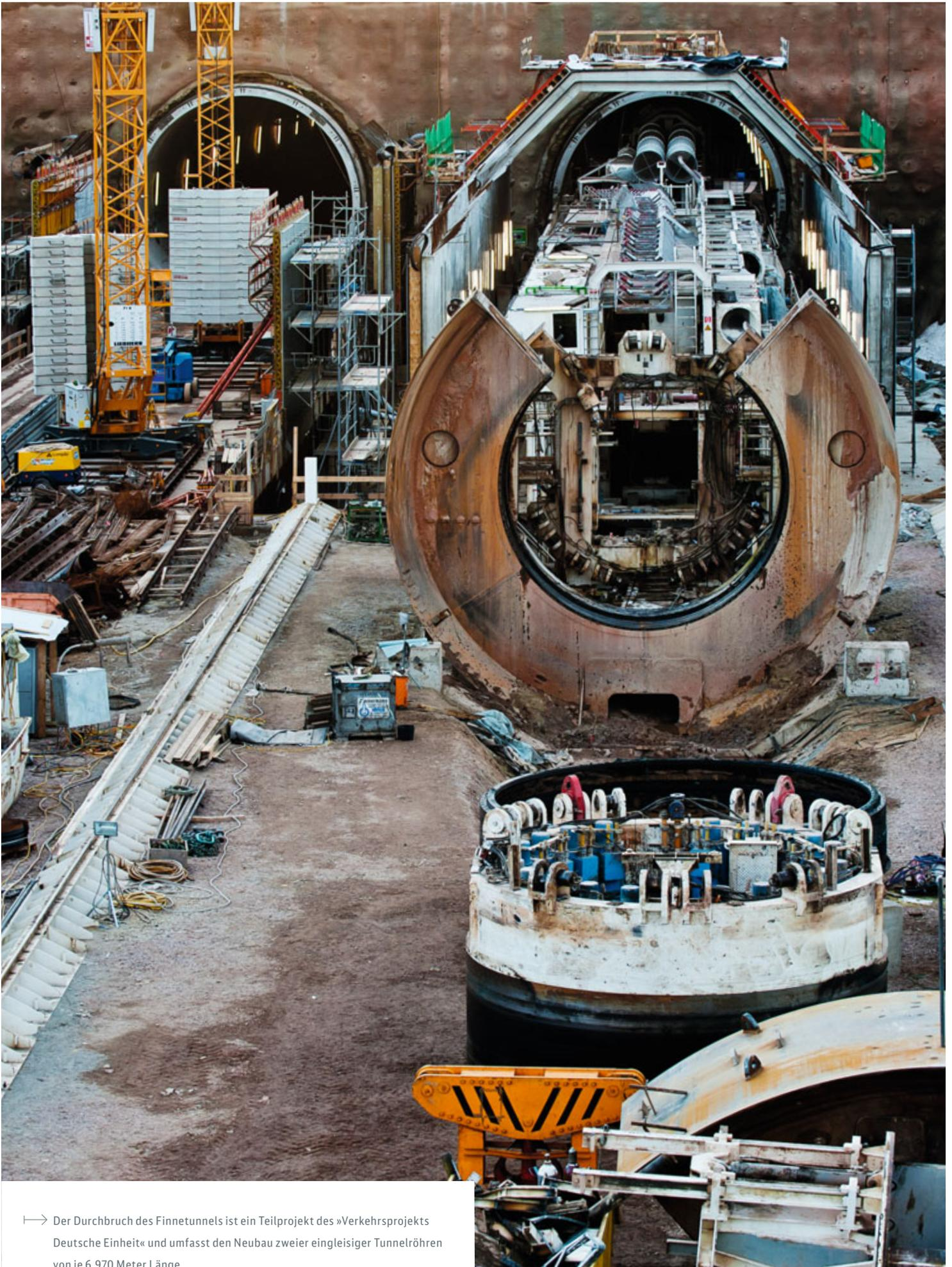
→ Der Durchbruch des Finnetunnels ist ein Teilprojekt des »Verkehrsprojekts Deutsche Einheit« und umfasst den Neubau zweier eingleisiger Tunnelröhren von je 6.970 Meter Länge.
